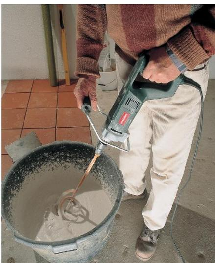
Рисунок 13 – Смешивание компонентов полимербетонной смеси
